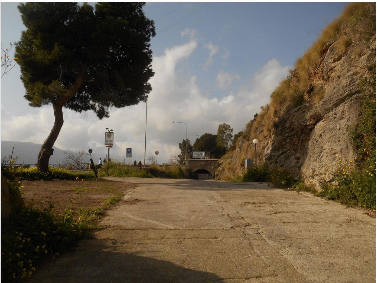
Tratto in prossimità del portale Est della Galleria di Monreale
