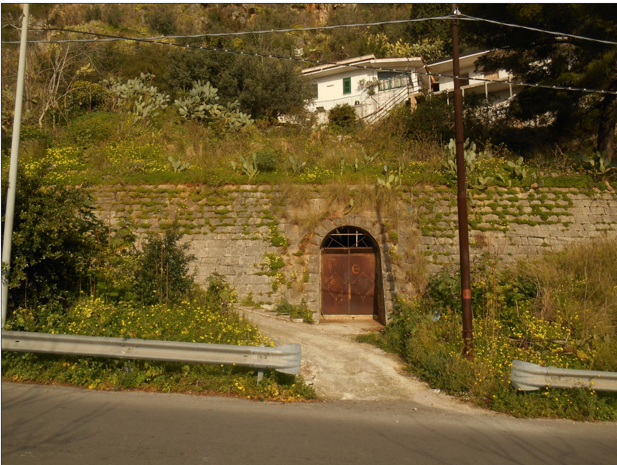
Muro di contenimento e tombino scolo acque
